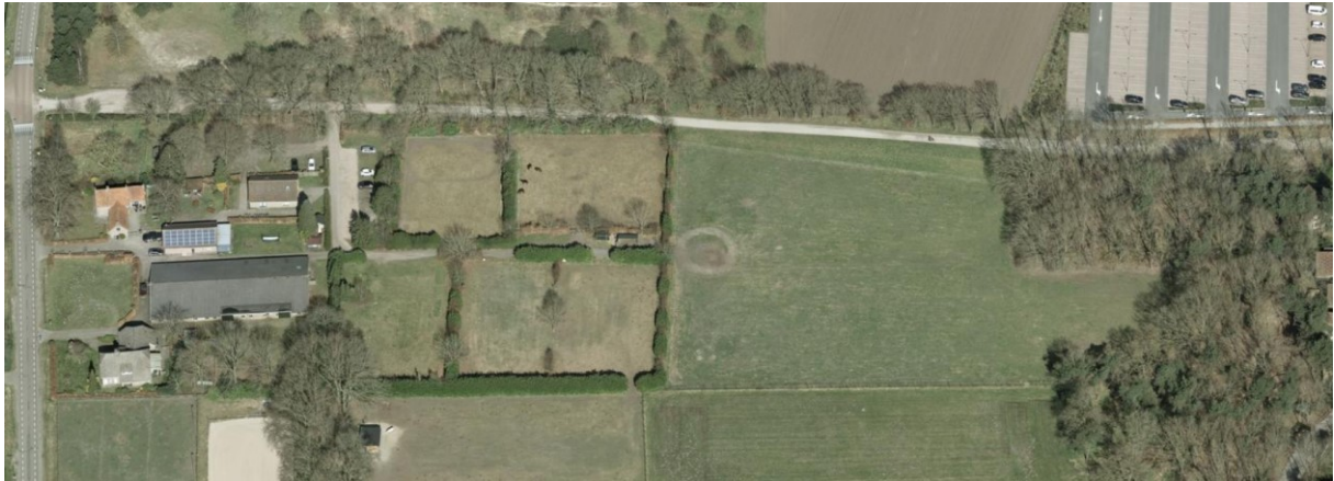
Luchtfoto huidige situatie totaal plangebied
