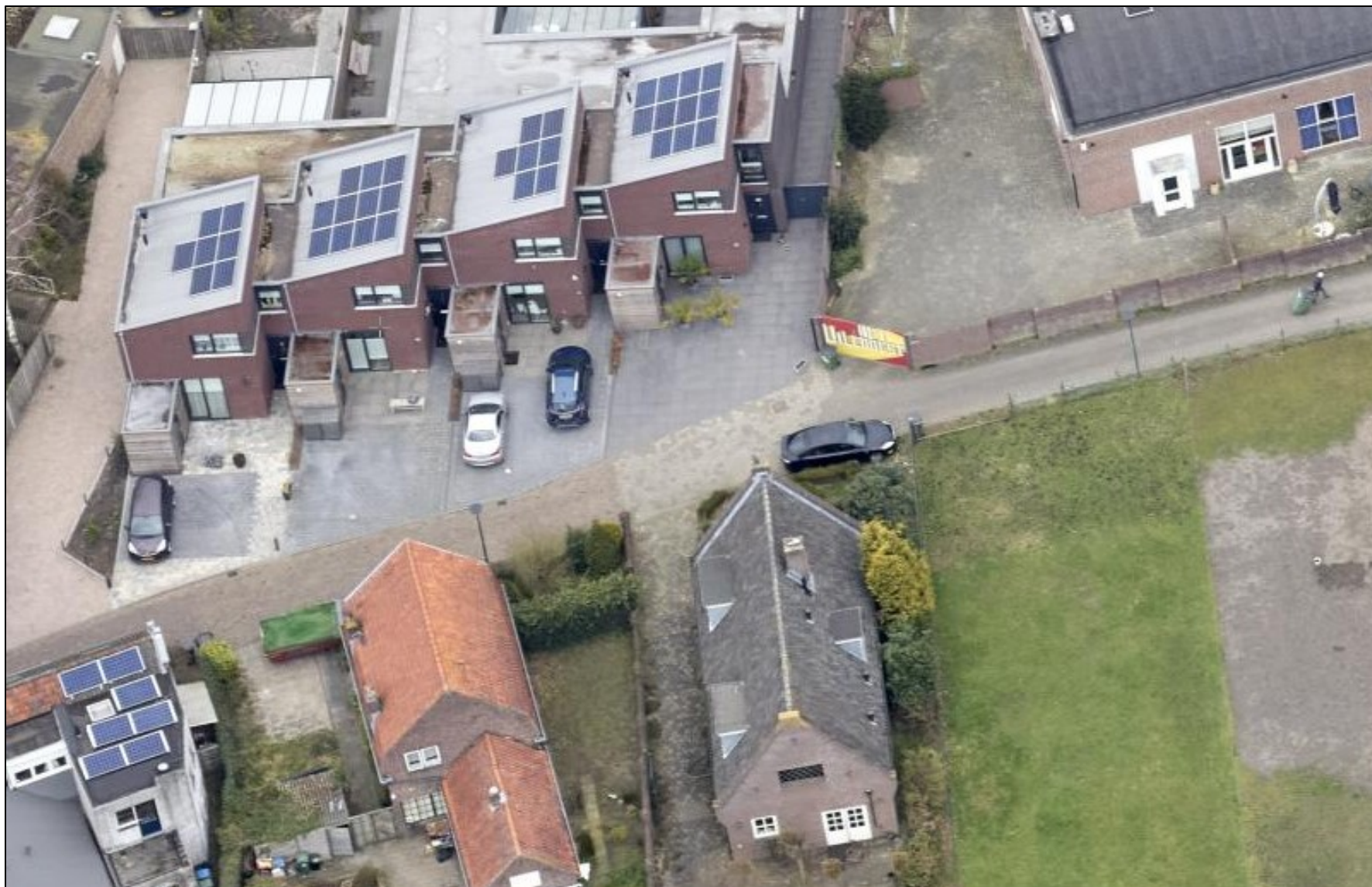
Afbeelding 4: luchtfoto Slagboom en Peeters d.d. 22 maart 2021 Weteringstraat te Loon op Zand, met rechtsonder het plangebied Weteringstraat 15B.
